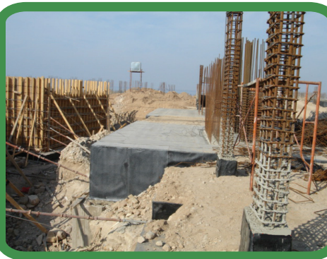
فندق كراون بلازا - البحر الميت
